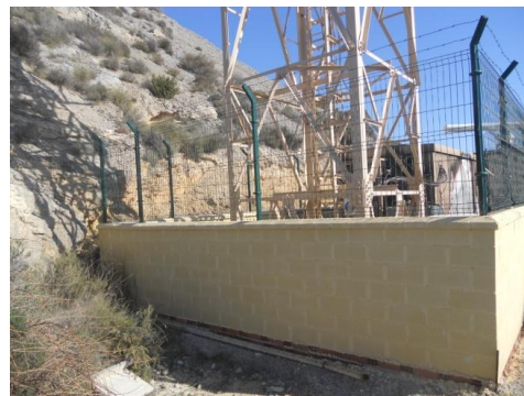
Valla perimetral existente
