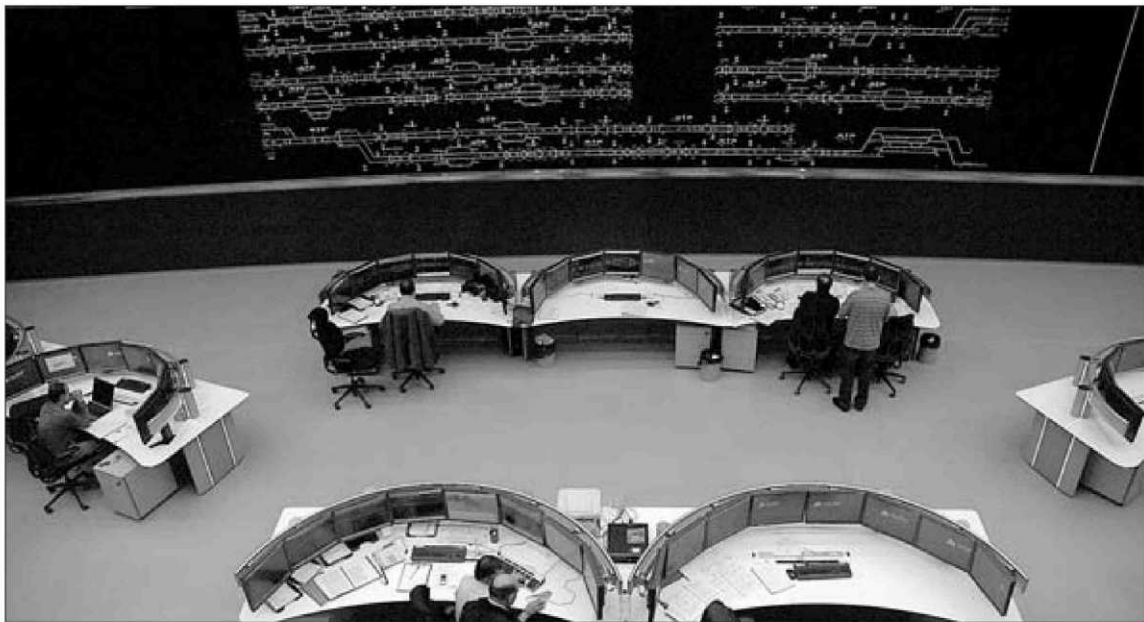
Centro de control de la línea Madrid-Valencia situado en Albacete y equipado con el sistema Da Vinci de Indra. A. R. A.
