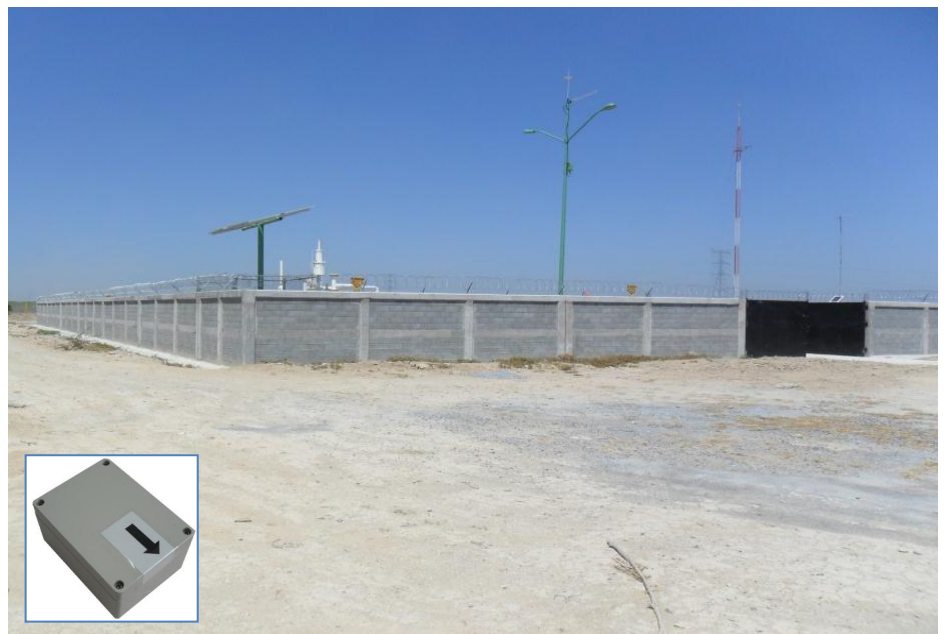
Detección perimetral de intrusos en la instalación. México
